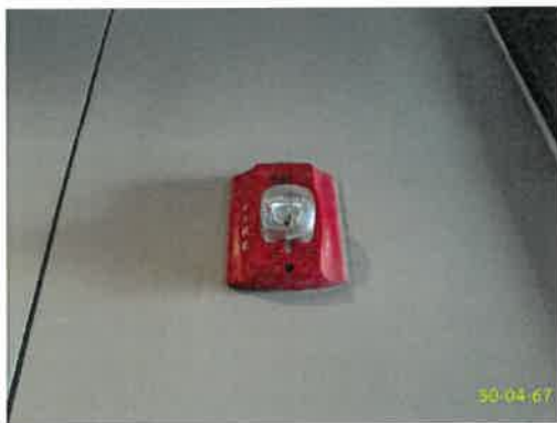
เครื่องแจ้งเหตุด้วยเสียงลำโพงและแสงไฟกระพริบเตือนอัคคีภัย
